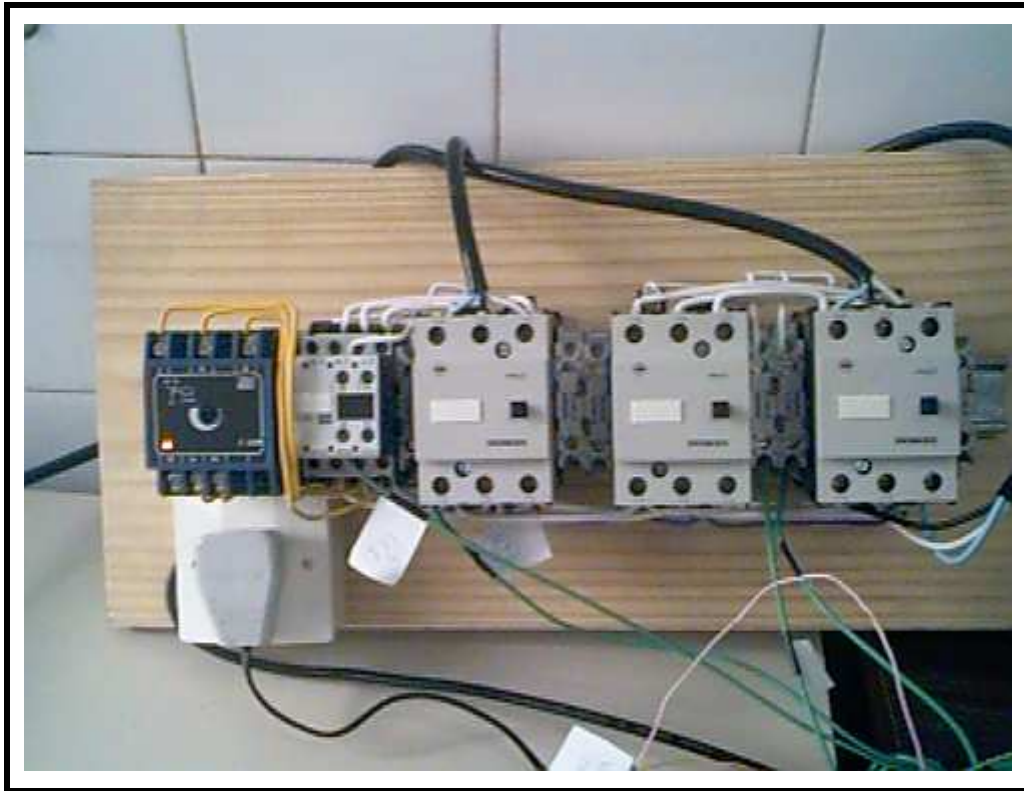
FIGURA 46 – CIRCUITO DE INTERTRAVAMENTO
